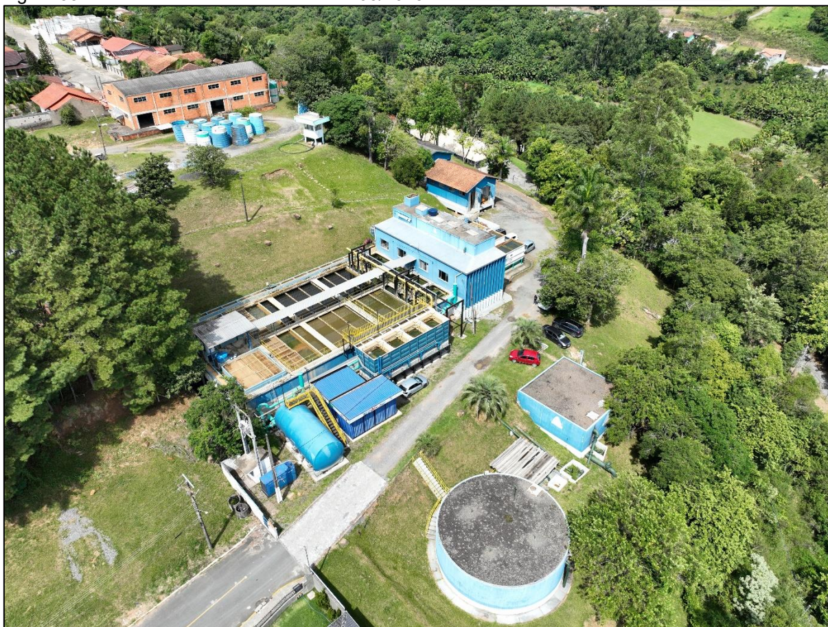
Figura 38: Vista aérea da ETA Rio do Sul – 03/2025.
