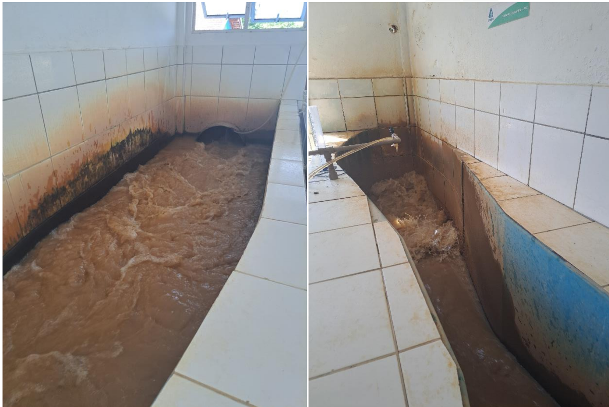
Figura 42: ETA Rio do Sul - Canal de entrada – Calha Parshall e dosagem de coagulante - ETA de concreto armado – 03/2025.
