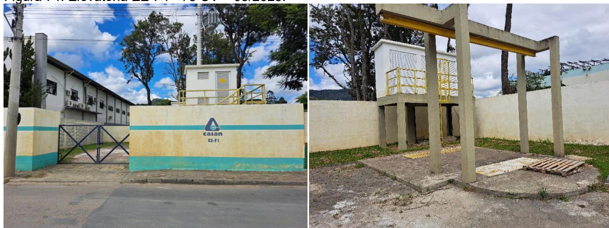
Figura 74: Elevatória EE-F1 - 75 CV – 03/2025.
