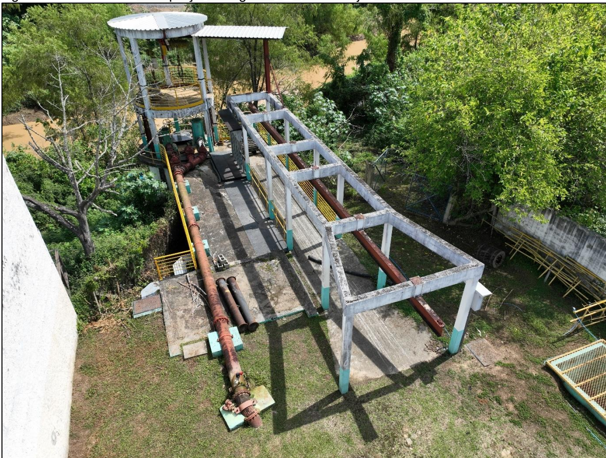
Figura 36: Vista aérea da captação de água bruta no Rio Itajaí do Sul – 03/2025.
