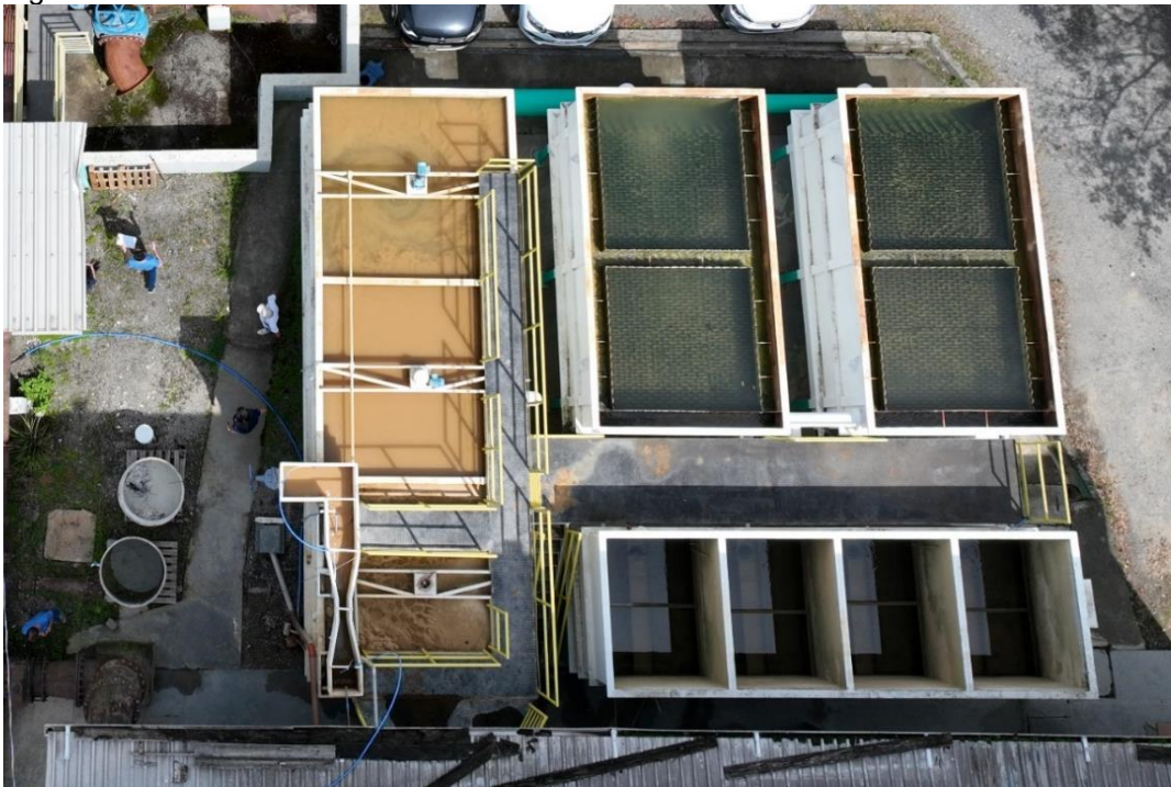
Figura 40: ETA Rio do Sul - Vista aérea da ETA metálica – 03/2025.
