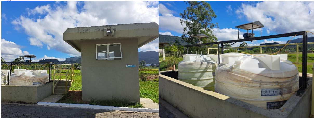
Figura 84: ETE Rio do Sul – Casa de cloro - 03/2025.
