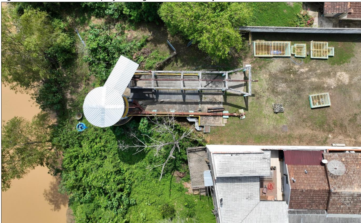
Figura 35: Vista aérea da captação de água bruta no Rio Itajaí do Sul – 03/2025.
