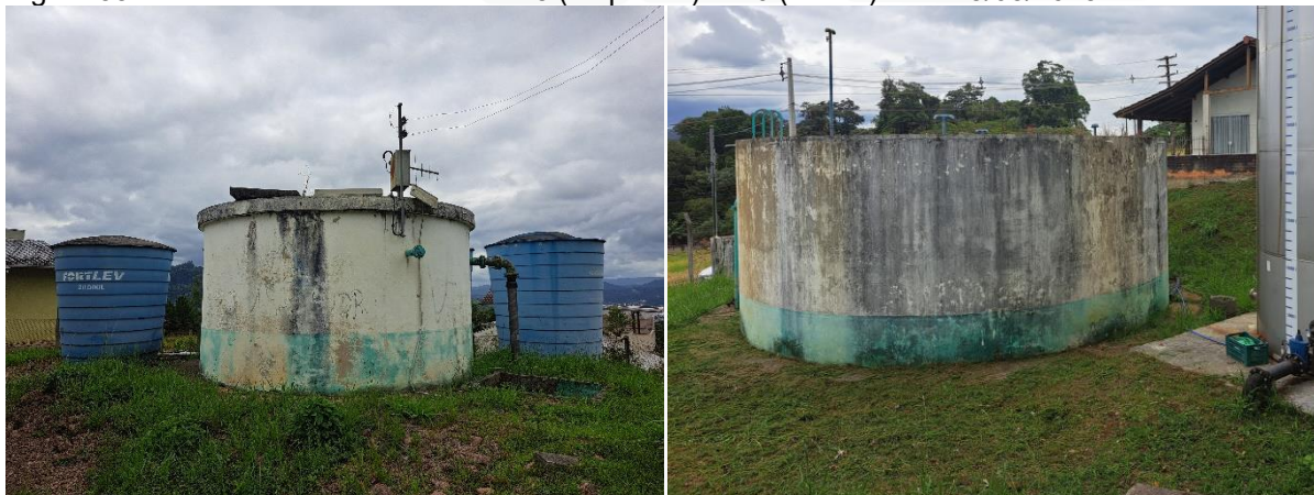
Figura 58: Reservatórios de concreto R18 (esquerda) e R6 (direita)– em 25/03/2025.
