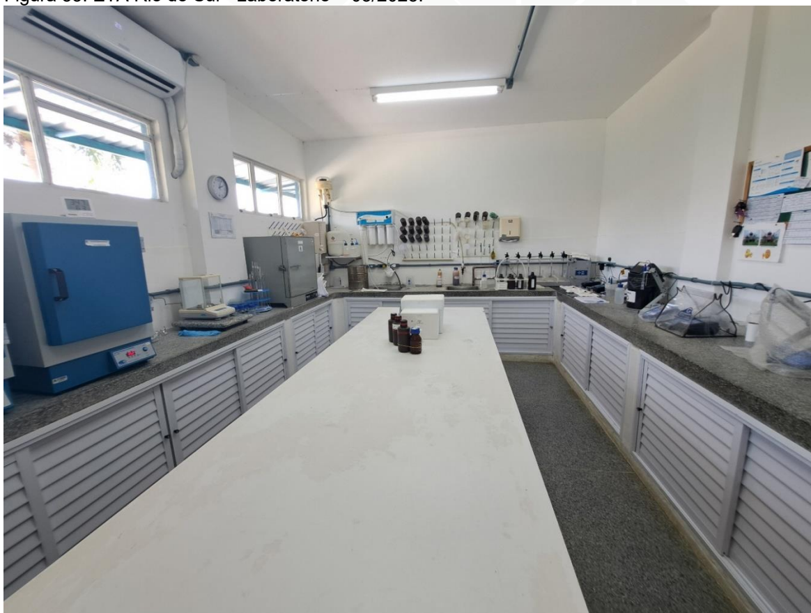
Figura 53: ETA Rio do Sul - Laboratório – 03/2025.
